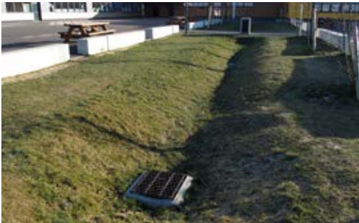
Cette noue récupère les eaux pluviales de la cour de récréation.
