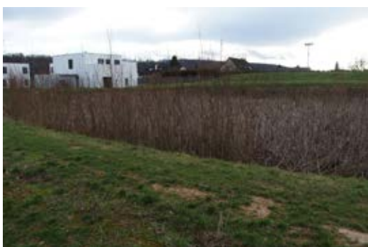
Exemples de deux types de bassins de rétention.
