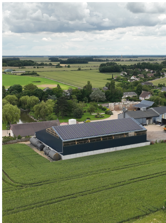
Panneaux photovoltaïques sur bâtiment agricole - EARL des Authieux
